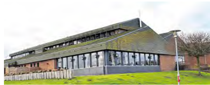
Zu Kasernenzeiten wurde das „Heimat“-Gebäude auf der Freiheit von der Bundeswehr als Mannschaftsheim genutzt. FOTO: FBÜ
